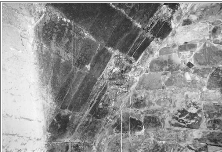
Der gewölbte Keller des Prinzenbaus. Cave voûtée du Bâtiment des Princes.
